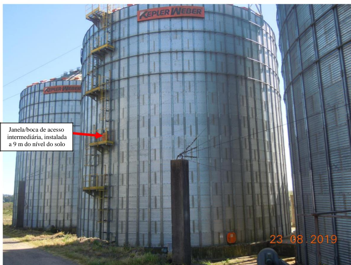
Figura 6. Silo de armazenamento de grãos nº 09 – local de acesso pelos trabalhadores.
