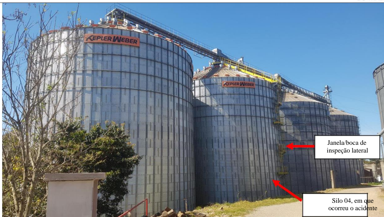
Figura 5. Silos de armazenamento de grãos.
