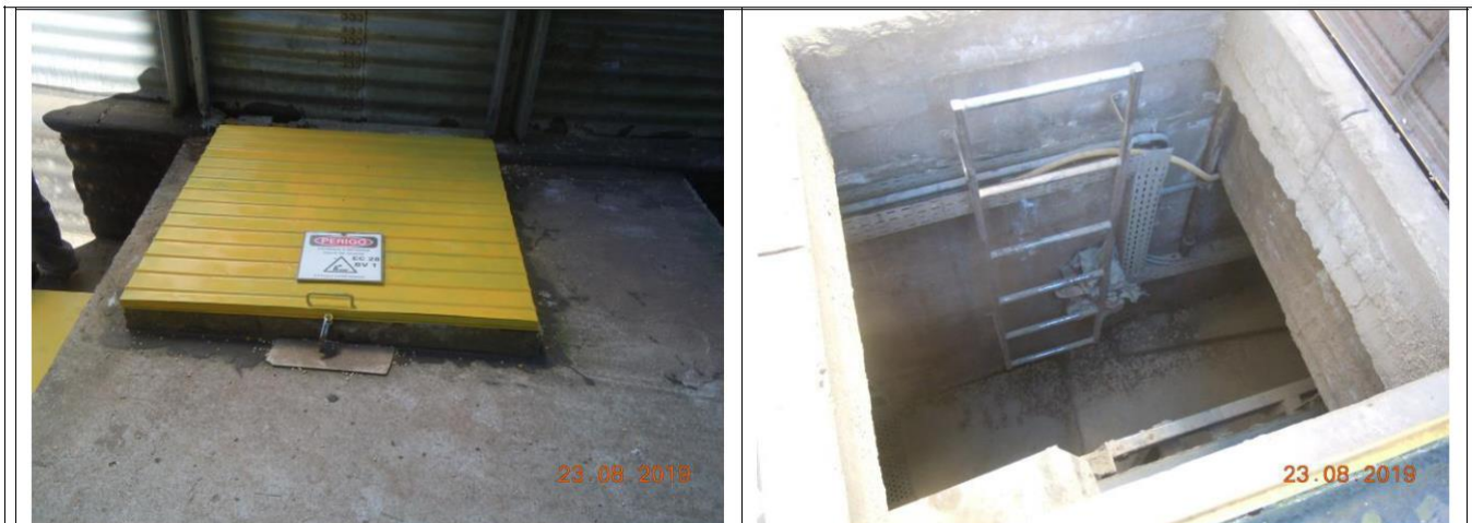
Figura 8. Janela de acesso ao túnel
