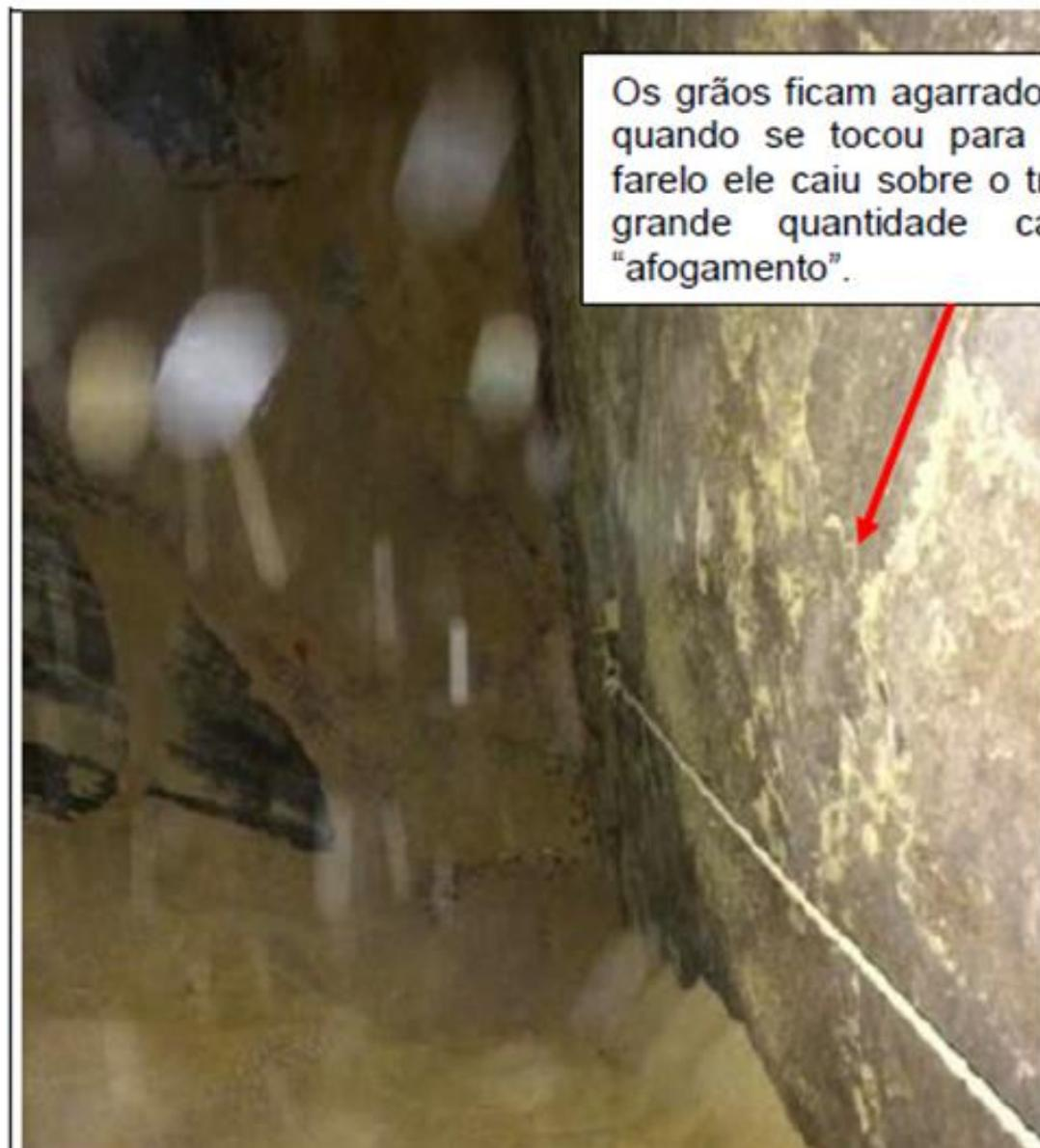
Os grãos ficam agarrados na parede e quando se tocou para quebrar esse farelo ele caiu sobre o trabalhador em grande quantidade causando seu "afogamento".
