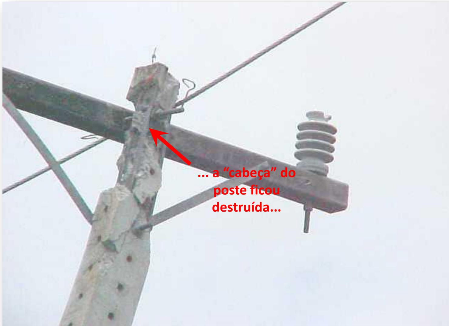
Podemos perceber pela imagem que o cabo ficou em contato com as ferragens expostas. Não sabemos se o poste já se encontrava deteriorado ou se o impacto é que causou a quebra do revestimento da estrutura.
