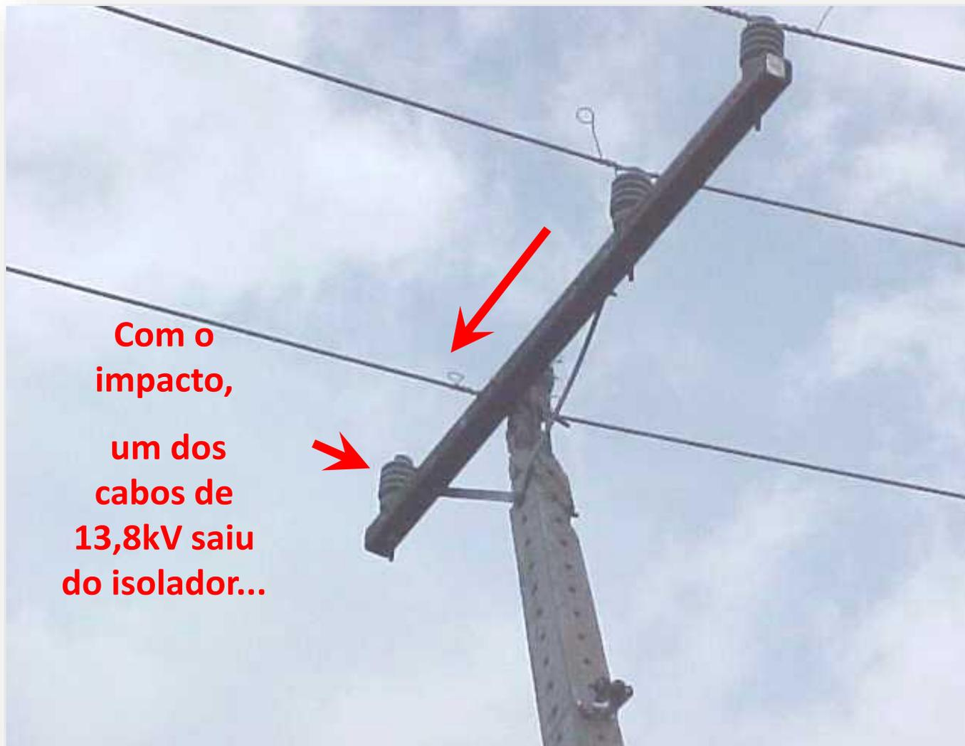
Na realidade o cabo não caiu sobre o veículo apesar de ter se soltado do isolador. Porém o cabo ficou em contato com a parte superior do poste.
