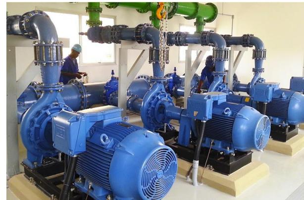
Verifique a existência de vazamentos na tubulação de recalque.
